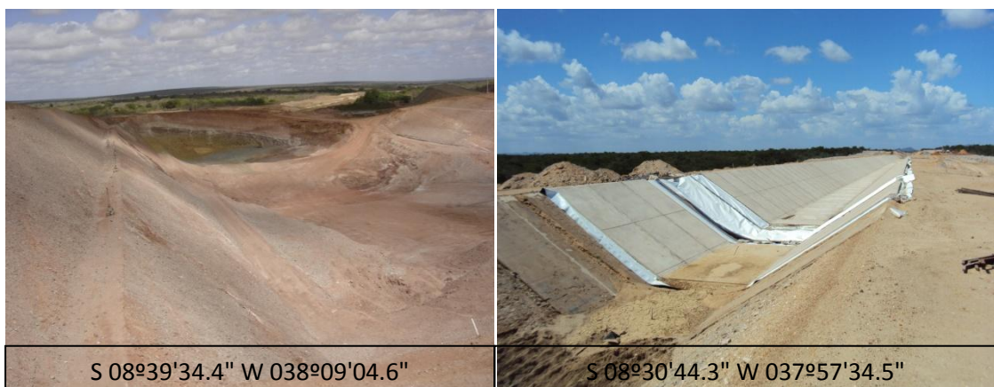
Figura 6 - Supressão de vegetação para as obras de transposição do Rio São Francisco
