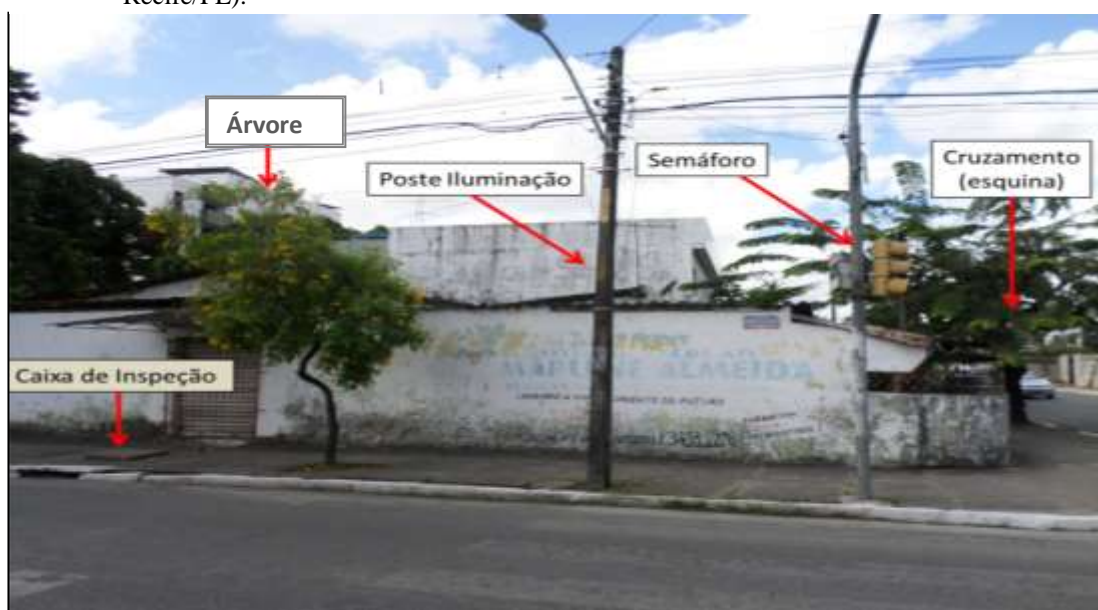
Figura 15. Elementos presentes na calçada que foram observados para aplicação dos parâmetros e identificação de locais para novos plantios (Rua Lindolfo Color – Engenho do Meio-Recife/PE).
